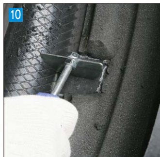
10 スクラッチャーで削りカスを除去し、表面を滑らかにする
